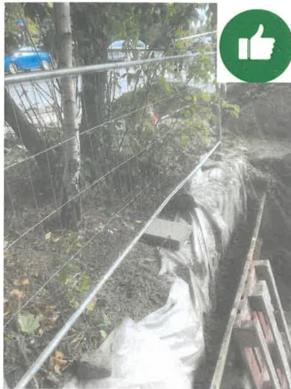
ODKRYTE KORZENIE ZWILŻYĆ I PRZYKRYĆ GEOWŁÓKNINĄ I NAWADNIAĆ REGULARNIE ABY NIE DOPUŚCIĆ DO PRZESYCHANIA
