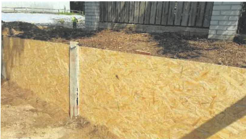
Fot. 7 Prawidłowo wykonany ekran z podłożem biologicznie czynnym o charakterze szalunku traconego w ścianie wykopu [fot. IGR, 2016]
