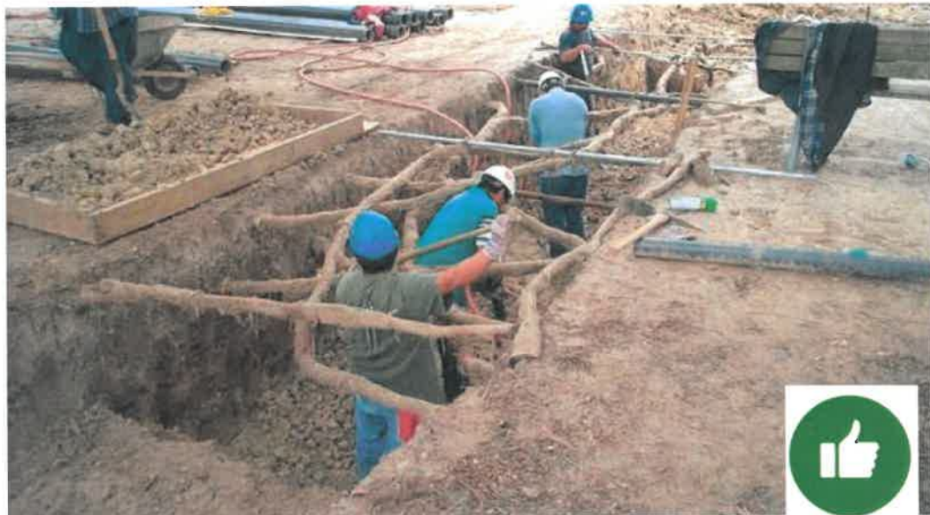
PRAWDŁOWE PROWADZENIE WYKOPÓW LINIOWYCH W STREFIE KORZENIOWEJ: W PRZYPADU WYSTĘPOWANIA GRUBYCH KORZENI NALEŻY JE POZOSTAWIĆ
