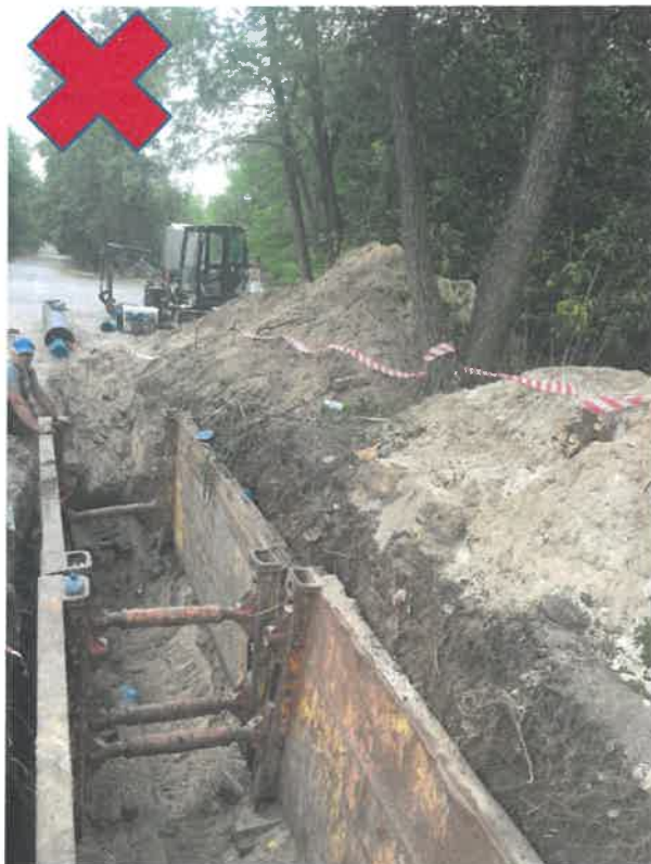
NIEDOPUSZCZALNE PROWADZENIE WYKOPÓW LINIOWYCH W STREFIE KORZENIOWEJ: POURYWANE I ODKRYTE KORZENIE (ŚCIANĘ WYKOPU NALEŻY PRZYGOTOWAĆ PRZED OSADZENIEM SZALUNKU)
