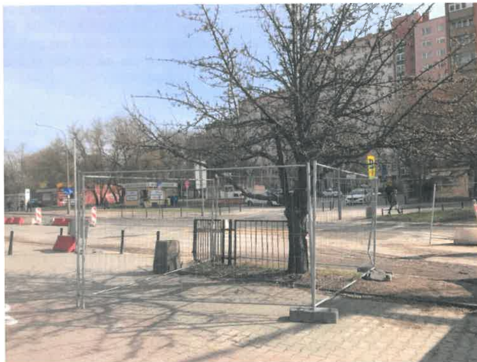
Fot. 5 Przykład wygradzenia drzew z terenu budowy w Strefie Ochronnej Zieleni [fot. IGR, 2022]
