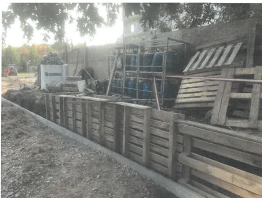
Fot. 8 Sposób zabezpieczenia wykopu – ekran z palet, folii budowlanej i podłoża biologicznie czynnego – etapy wykonywania prac [fot. IGR 2022]
